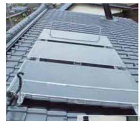
集熱部のみ屋根の上、貯湯タンクは下にあり、加圧ポンプにより給湯します。既設の給湯に直結するため、太陽熱が不足の場合は給湯器に切り替わり、加熱することが可能なタイプです。
