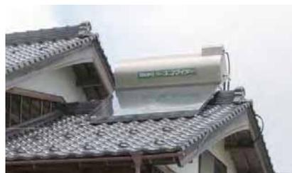
基本的には建物の屋根の上に設置して、太陽を受光し、パネル上のタンクに貯湯し、自然落差で給湯するタイプ。
